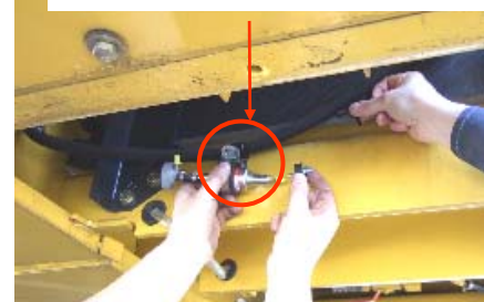
Установка топливного насоса
