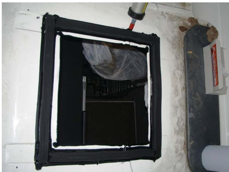
Установить накрышный блок с первого раза используя предварительную разметку
