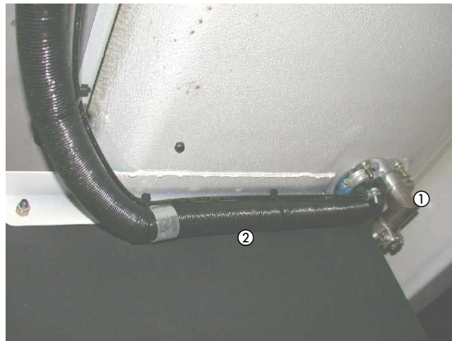
① 90° Agasrohrbogen / 90° exhaust pipe bend ② Flexibles Verbrennungsluftrohr / Flexible combustion air pipe
